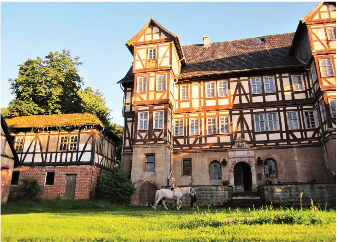
Foto: das Gutshaus von 1576 auf dem Rittergut Aue, hier sollen ein Mehrgenerationenleben entstehen
